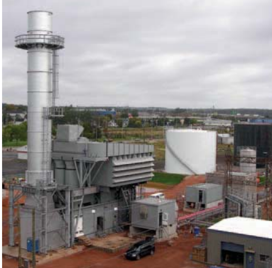
La nouvelle centrale à turbine à combustion de 50 MW de Maritime Electric améliorera la fiabilité et la sécurité de l'approvisionnement de l'Île-du-Prince-Édouard.
